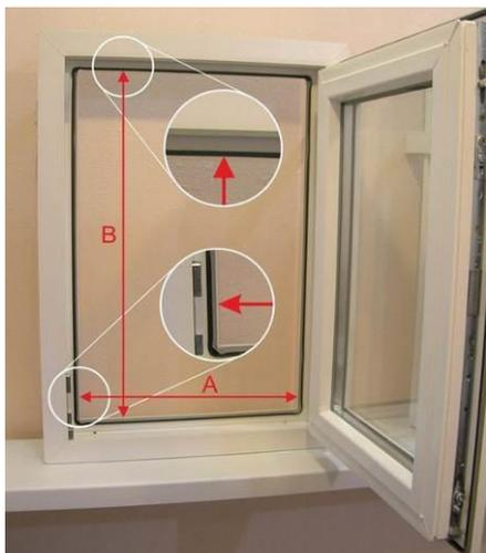
Снимается размер ширина и высота проема в мм, не округлять.
